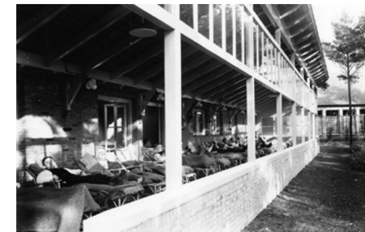
Sanatorium Berg en Bosch te Bilthoven, waar relatie met buiten goed zichtbaar is
