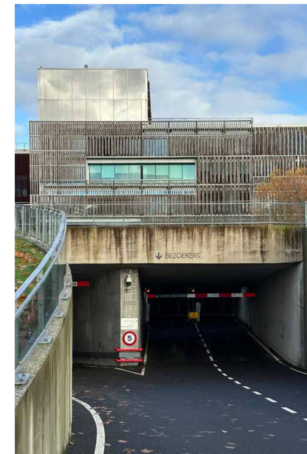
Entree parkeergarage aan de zuidzijde
